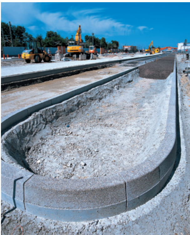
Pose de bordures hautes
