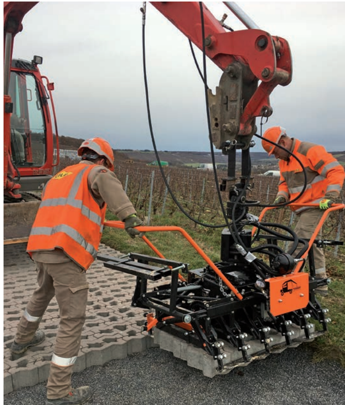
Pose mécanique de pavés CEPAGE sur le chantier de BASLIEUX F-54620
