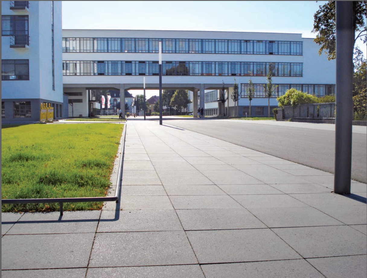
Pavés City-Truck 60 x 60 cm et un pavé spécial comportant des réservations pour bordures (voir dessin technique)
