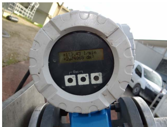
Mesure du débit pendant essai
