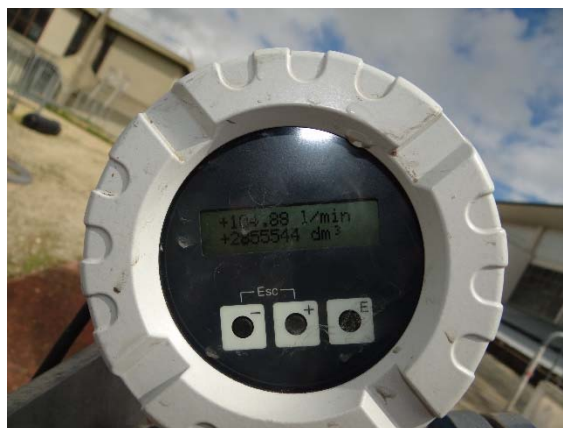
Mesure du débit pendant essai
